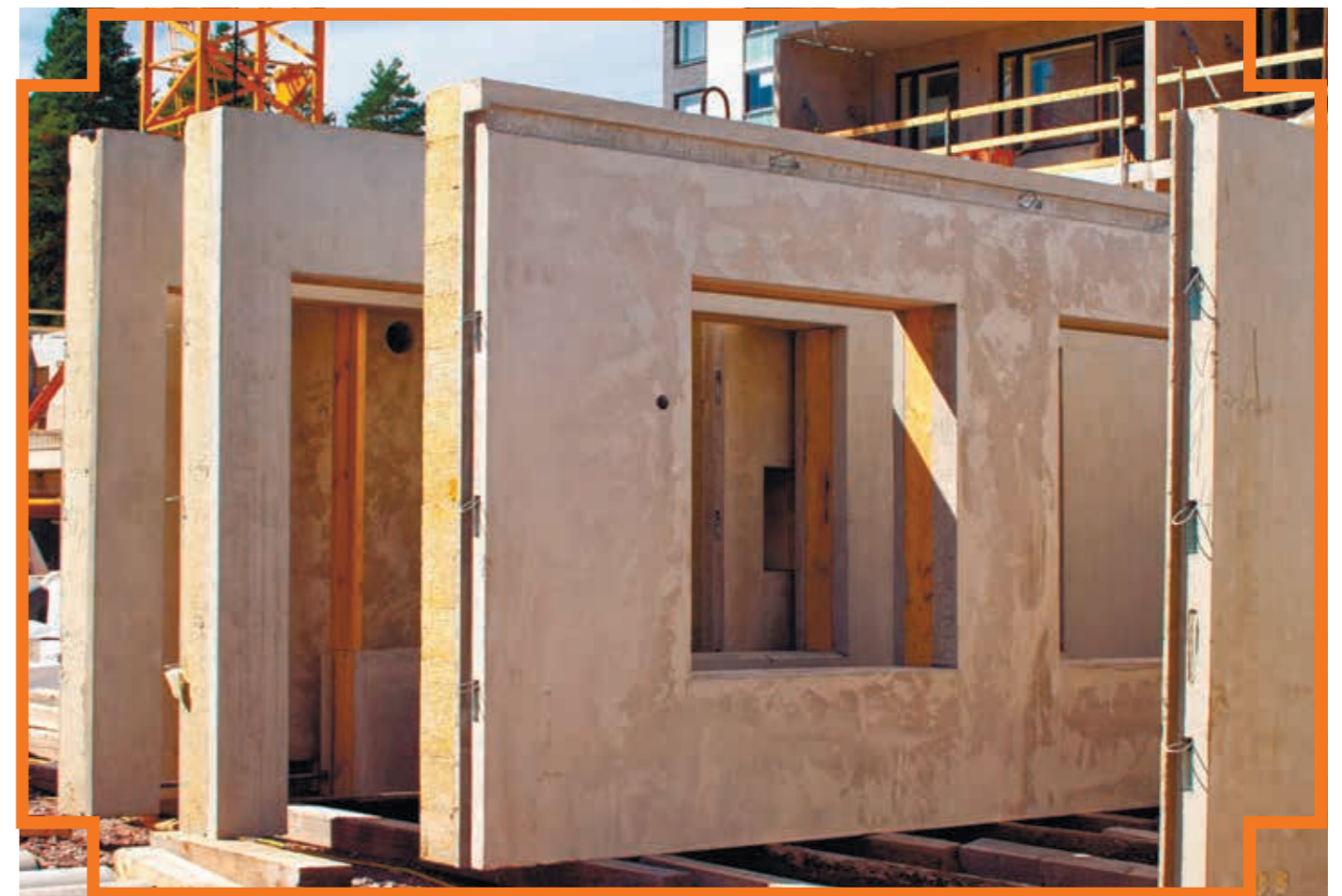
Сборная трехслойная «сэндвич» панель Однослойная панель Длина: до 13 метров Высота: до 3,5 метров Возможна текстурная отделка поверхности панелей
